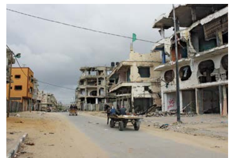
Shejaiya, Gaza: Das Gebiet wurde großflächig zerstört und ist heute mit explosiven Kriegsresten verseucht. – © Tom Shelton / Handicap International
