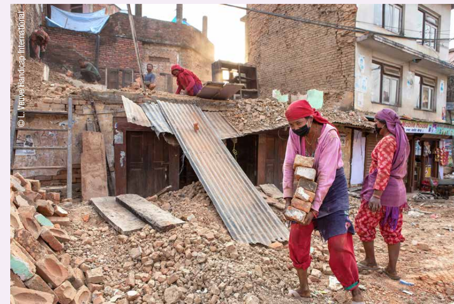
Nach dem Erdbeben in Nepal im April 2015 unterstützt Handicap International den Wiederaufbau des Landes.
